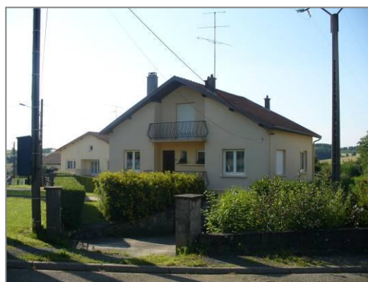
Construction des années 1980, rue de la Huillère.
